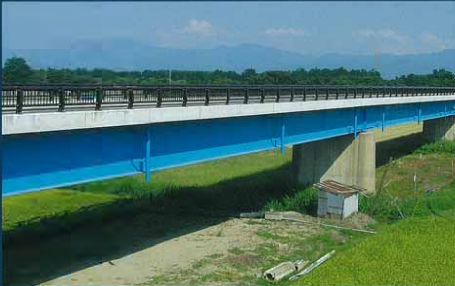
床版架材工(高強度軽量プレキャストPC床版)・大川橋 秋田県 施工: ビーシー橋梁JV
